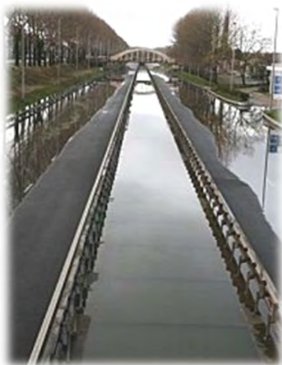
Dunkerque - Inondation de la voie rapide dans l'ancien canal de Mardyck
