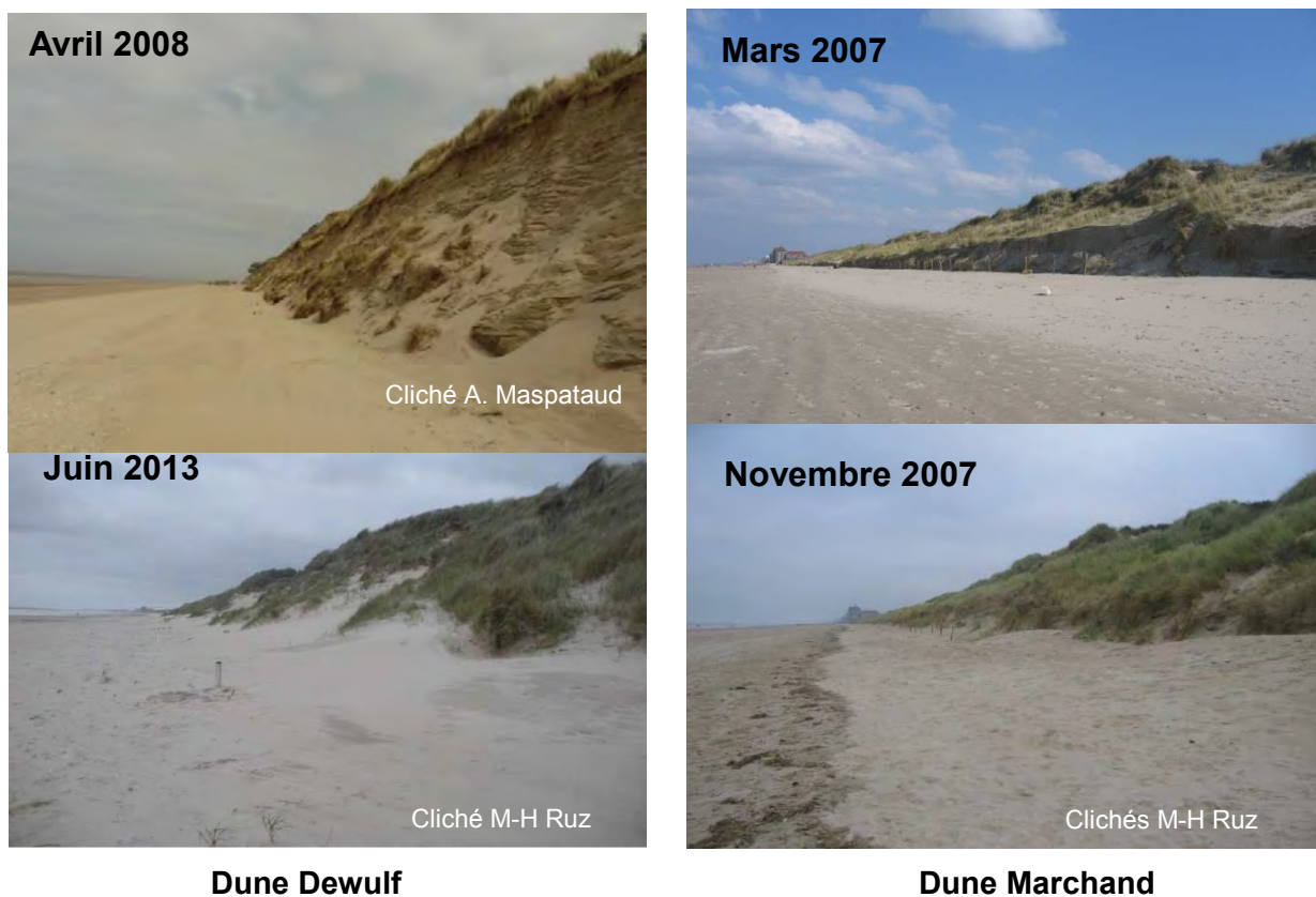
Figure 8 : Rétablissement post-tempête de versants dunaires à l'est de Dunkerque suite à des tempêtes en mars 2007 (Dune Marchand) et en mars 2008 (Dune Dewulf) ; la localisation de la Dune Dewulf et de la Dune Marchand est indiquée dans la Figure 4.
