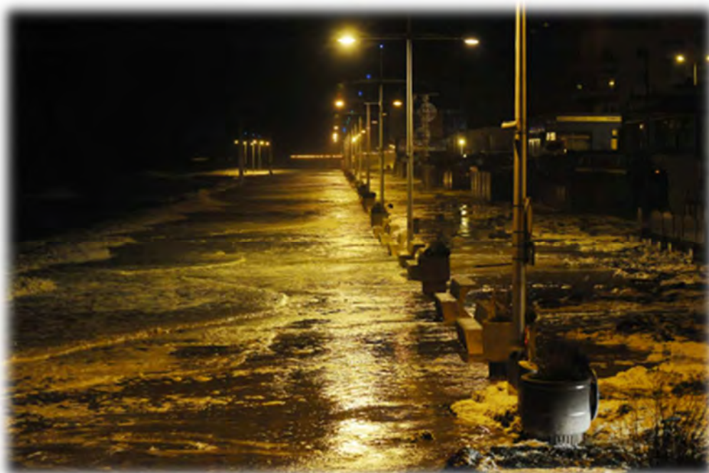
Figure 7 : Submersion de la digue des Alliés Dunkerque le 6 décembre 2013 lors d'une surcote de 1,26 m à pleine mer (source : La Voix du Nord).
