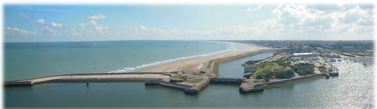
Figure 3 : Portes à la mer. Ouvrage Tixier. Dunkerque, Nord (source : Institution Interdépartementale des Wateringues).
