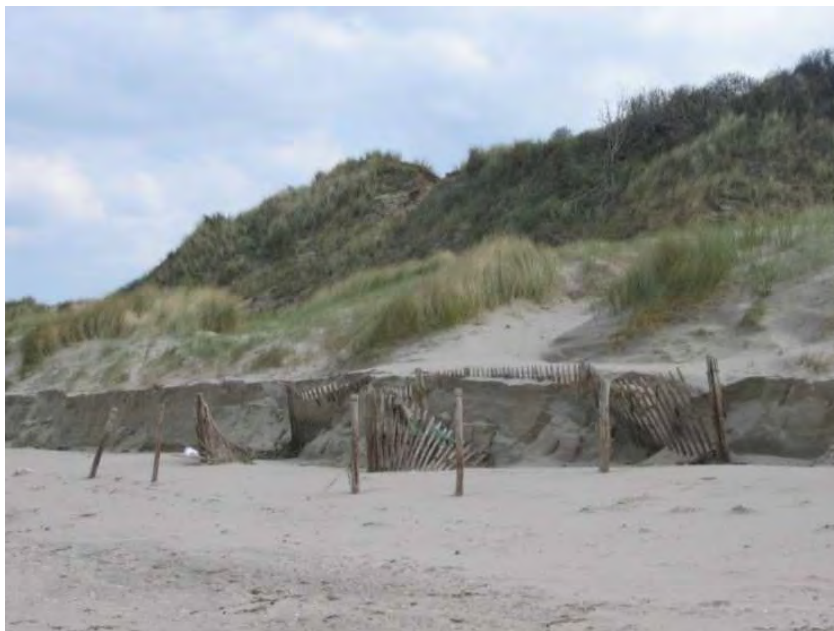
Figure 9 : Erosion partielle d'un bourrelet dunaire de haut de plage édifié à l'aide de ganivelles à l'avant de la Dune Dewulf pendant la tempête du 18 au 21 mars 2007 (cliché : M.H. Ruz, 25 mars 2007)
